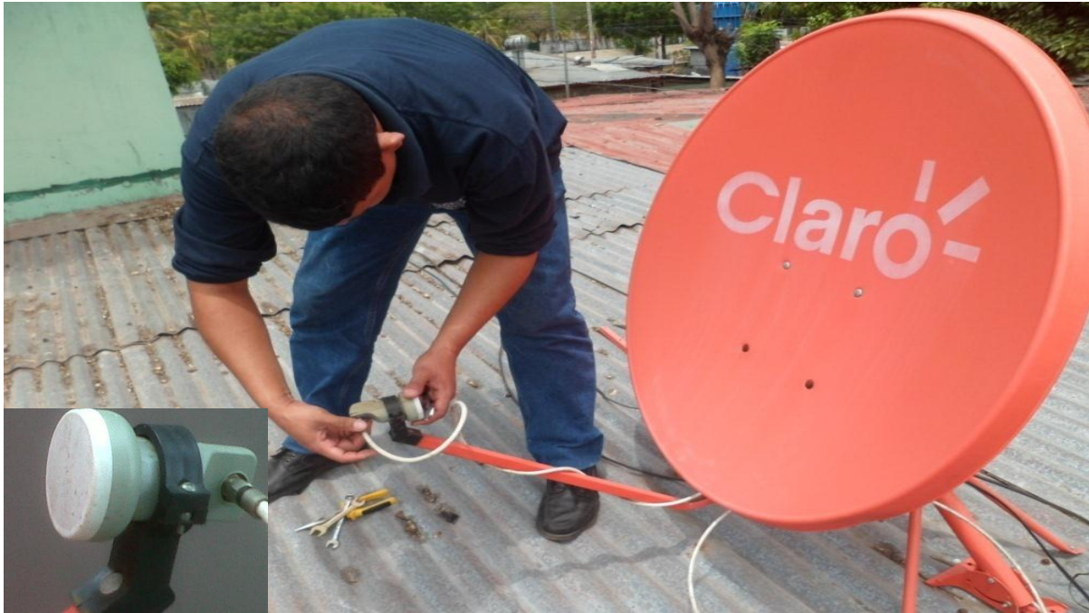
Figura #52 Instalación correcta del LNB
