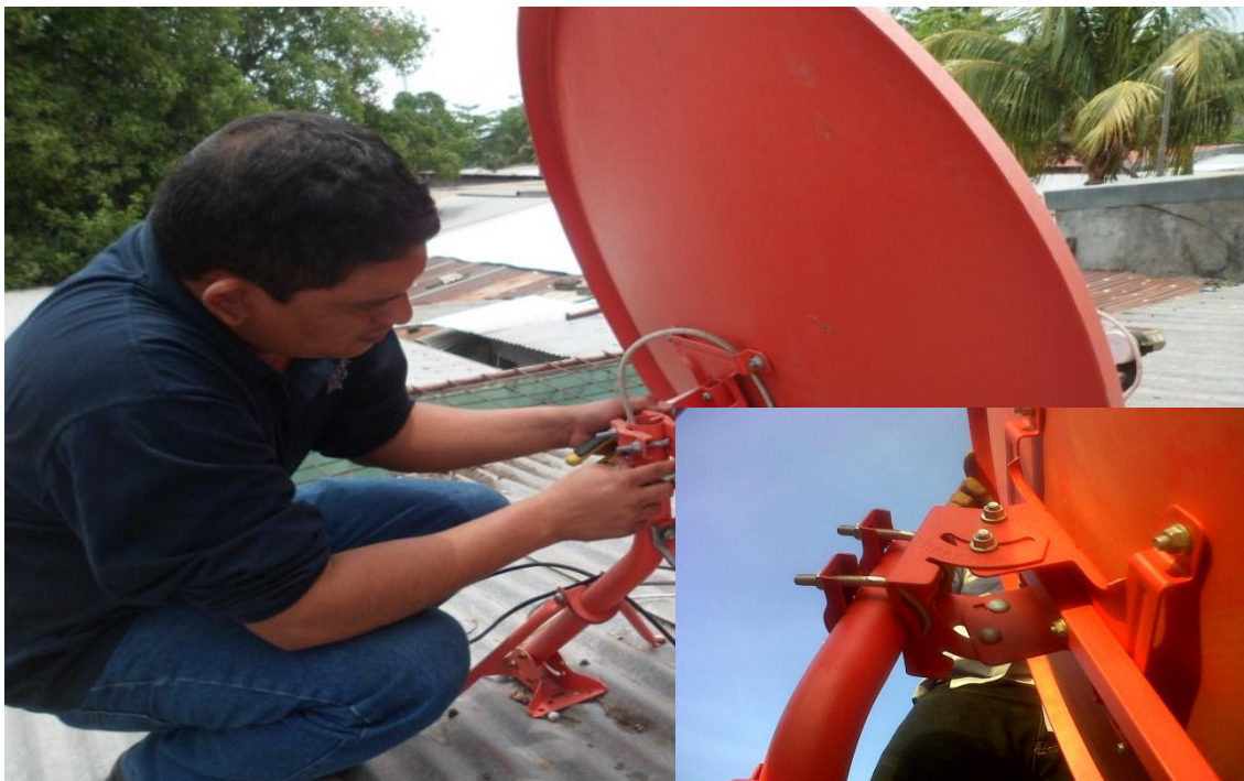
Figura # 51 acople de la antena
