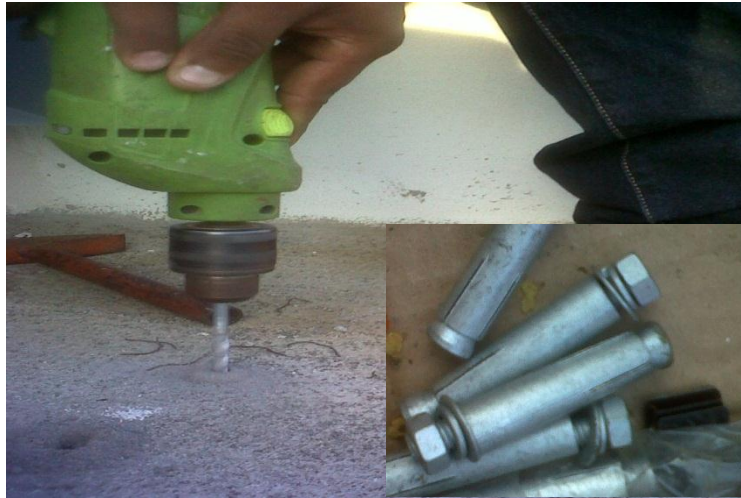
Figura #50 Perforación del terreno para la instalación
