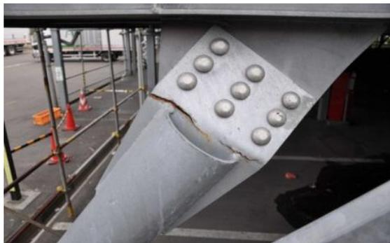
Figura 3.13 Rotura de la soldadura. Tomado de Manual para la inspección visual de puentes y pontones vol.1 (2006) Bogotá, Colombia.
