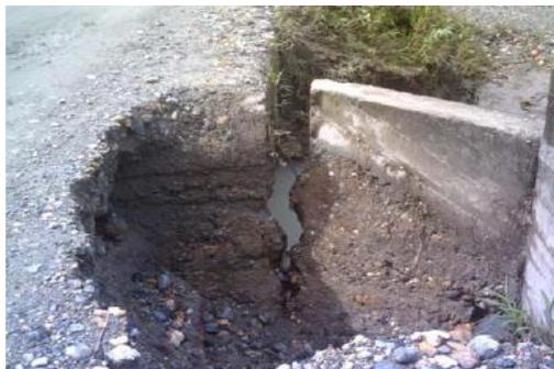
Figura 3.6 volcamiento en una aleta. Puente Pacarni, Choco.2004.Tomado de Manual para la inspección visual de puentes y pontones vol.1 (2006) Bogotá, Colombia.
