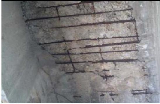
**Figura 3.8 Recubrimiento inadecuado o exposición del acero de refuerzo. Tomado de Manual para la inspección visual de puentes y pontones vol.1 (2006) Bogotá, Colombia.**
