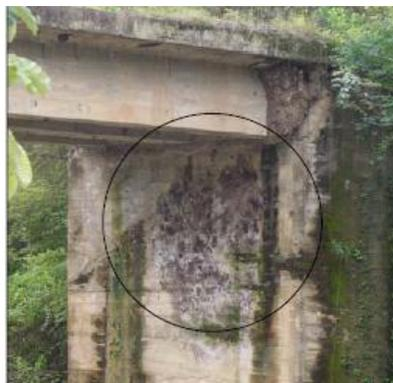
**Figura 3.9 Eflorescencia en el estribo del puente. Tomado de Manual para la inspección visual de puentes y pontones vol.1 (2006) Bogotá, Colombia**
