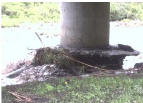
**Figura 3.10 Socavación en puente. Tomado de Manual para la inspección visual de puentes y pontones vol.1 (2006) Bogotá, Colombia**
