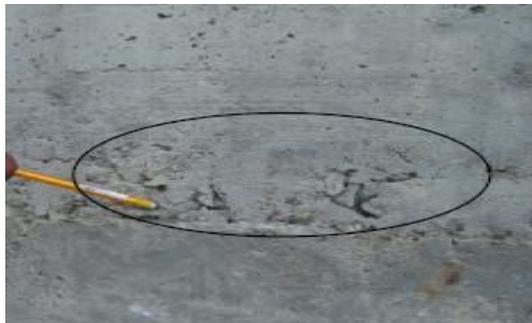
**Figura 3.7 Segregación en el concreto. Tomado de Manual para la inspección visual de puentes y pontones vol.1 (2006) Bogotá, Colombia.**
