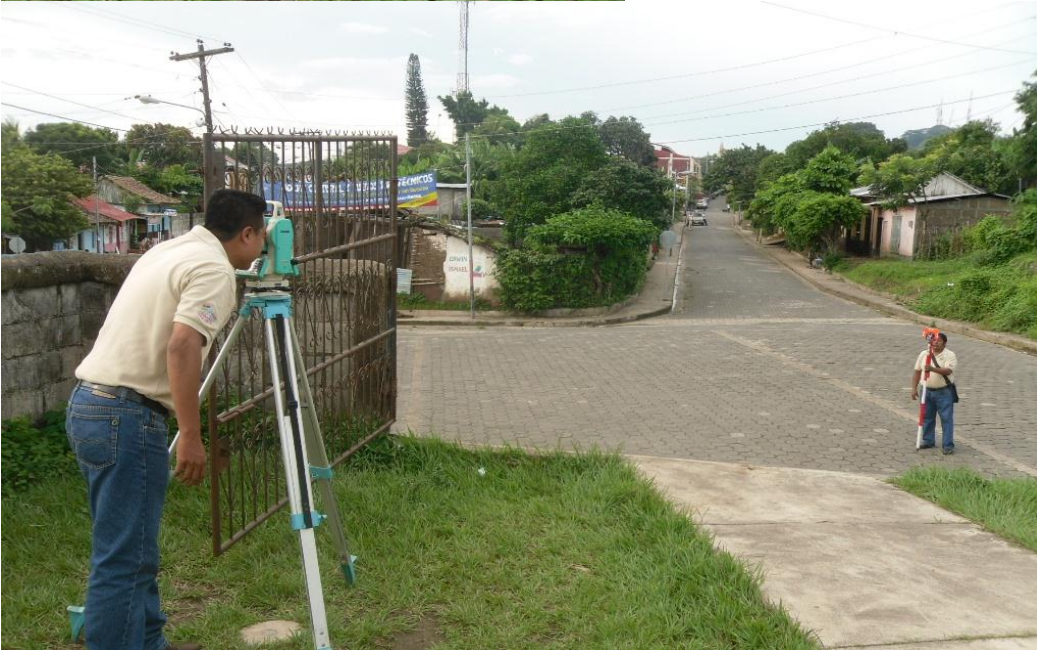
Punto geodésico Ermita San Silvestre. Levantamiento con estación total.
