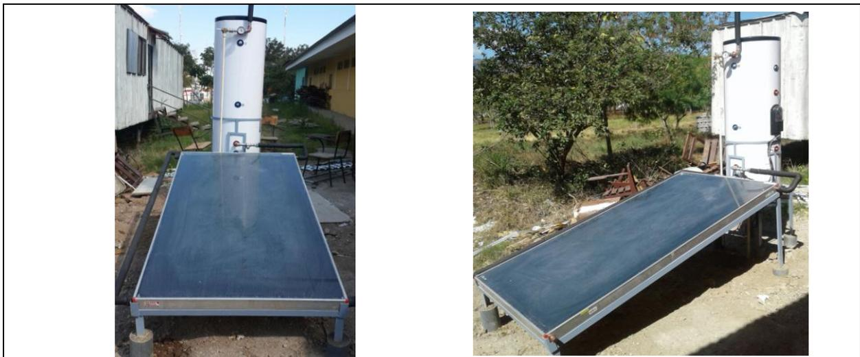
*Fig. No. 14 Sistema solar térmico instalado Costado Sur edificio de deportes y cultura*
