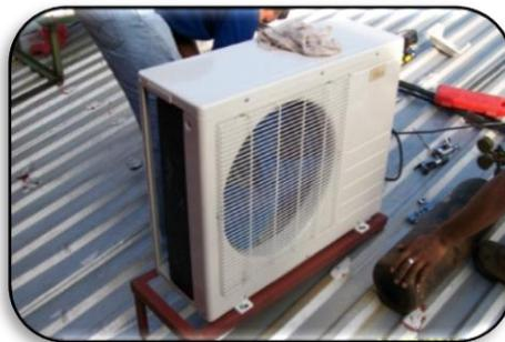
**Ilustración 51: Desmonta condensador**
