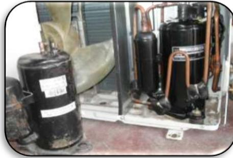
**Ilustración 69: Desinstalación de compresor**
