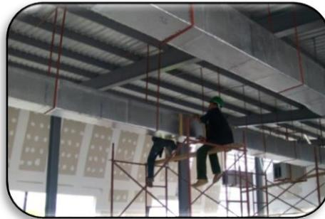
**Ilustración 56: Instalación de ductos**
