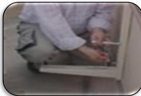
**Ilustración 46 Colocación de ménsula**
