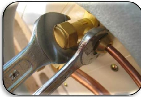
Ilustración 52: Desmonte de tubería
