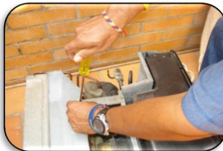
**Ilustración 24: Verificación de corriente**
