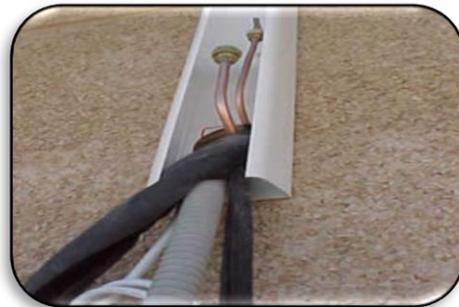
**Ilustración 68: Desinstalación tubos**
