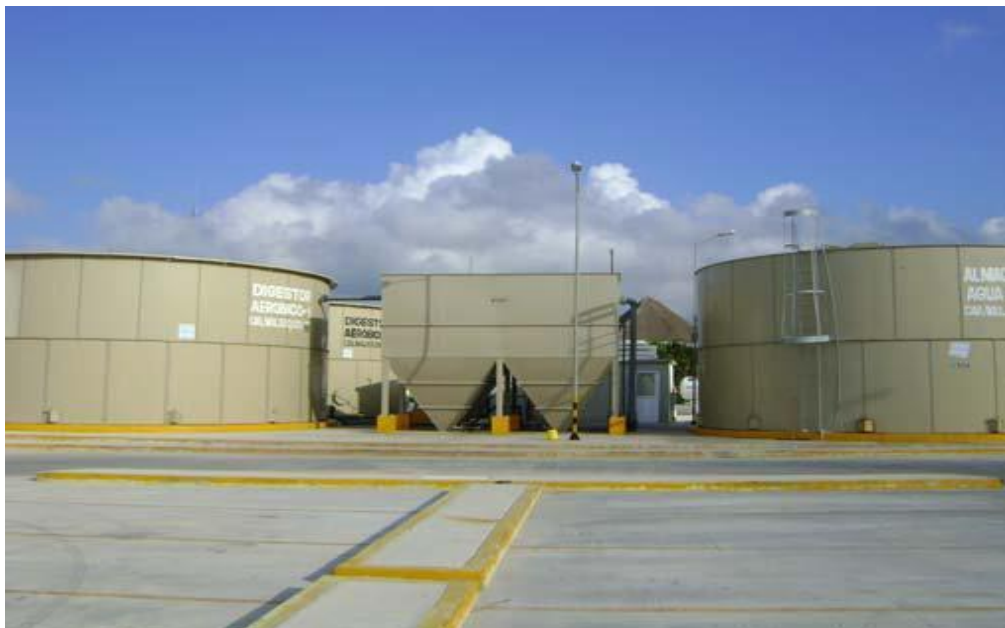
Imagen 3.11.7. Sistema de separación de lodos y tanques de almacenamiento de aguas residuales
