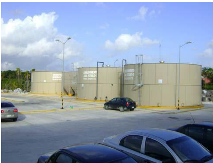
Imagen 3.11.4. Sistema de almacenamiento de aguas residuales y estacionamiento
