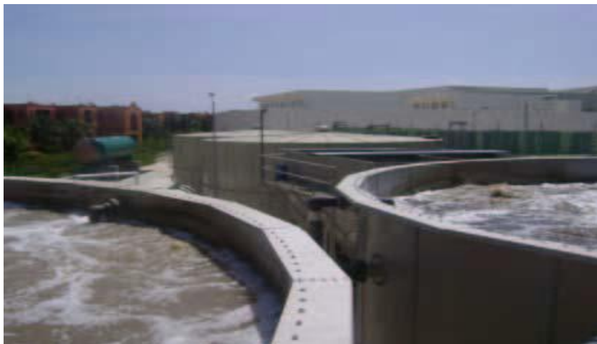
Imagen 3.11.9. Tanques de almacenamiento de aguas residuales
