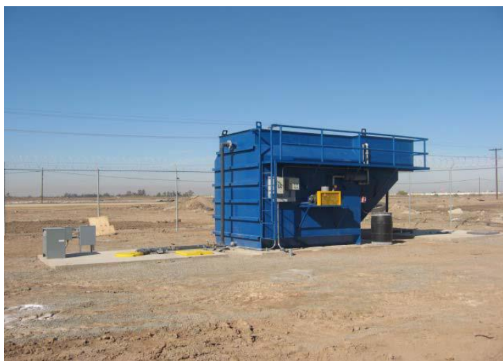
Imagen 3.11.1. Sistema de cloración
