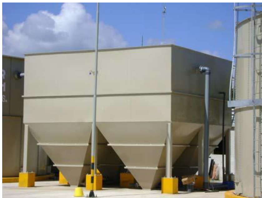
Imagen 3.11.3. Sistema de separación de lodos
