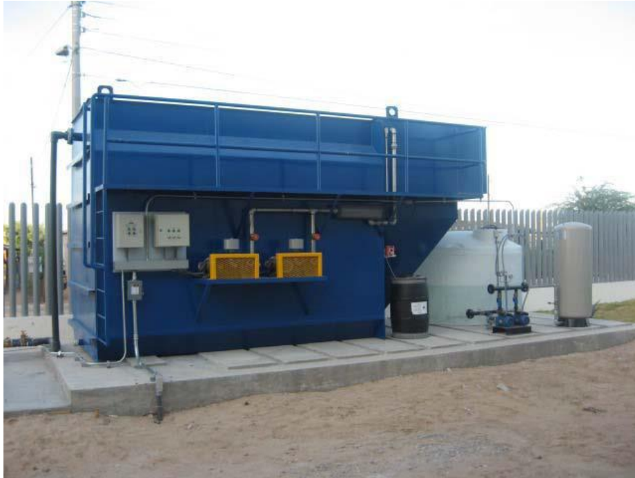
Imagen 3.11.3. Sistema de cloración
