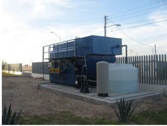
Imagen 3.11.2. Sistema de cloración
