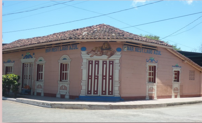
Ilustración 24 Vista exterior del Bar
