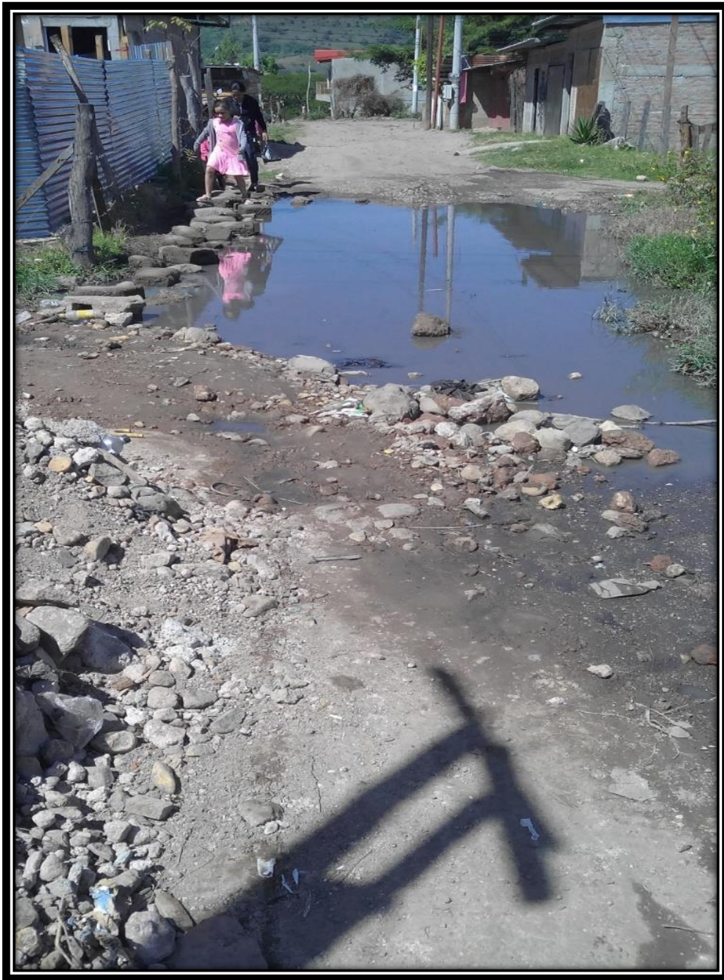
Foto N° 7. Calle del barrio Alexis Argüello
