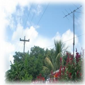
Foto N° 13 Fuente Propia Postes del tendido eléctrico
