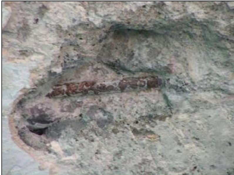
**Foto 27.-** Prueba del grado de corrosión del acero estructural en columna, C-5
