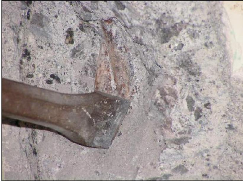
**Foto 25.-** Prueba del grado de corrosión del acero estructural en columna, C-3
