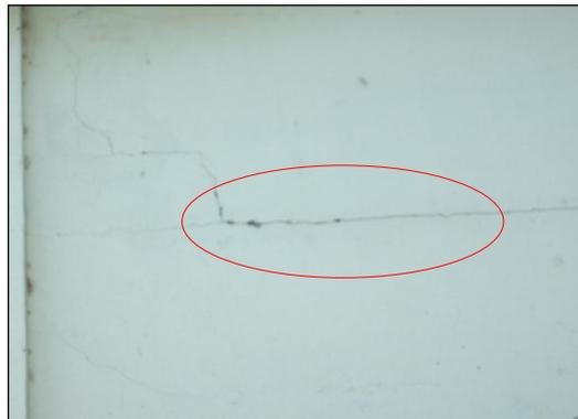
**Foto 15.-** Presencia de grietas en muro lateral de edificio de epidemiología
