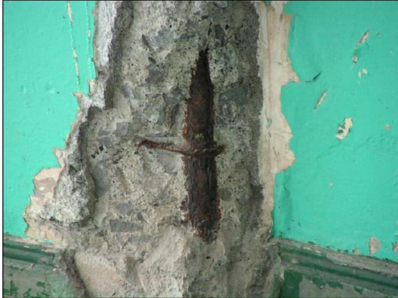
**Foto 23.-** Prueba del grado de corrosión del acero estructural en columna, C-1
