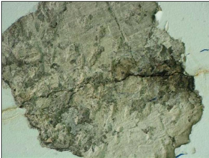
**Foto 26.-** Prueba del grado de corrosión del acero estructural en columna, C-4
