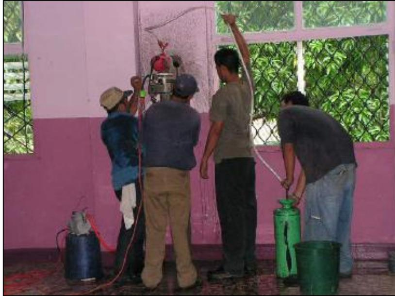
Foto 21.- Sitio de extracción de núcleos de pared norte del segundo piso
