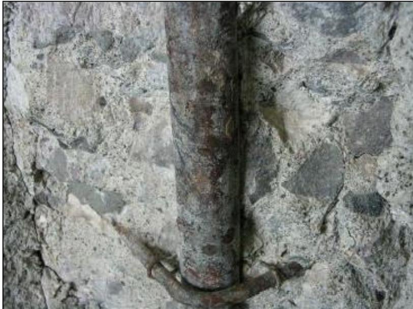
**Foto 24.-** Prueba del grado de corrosión del acero estructural en columna, C-2
