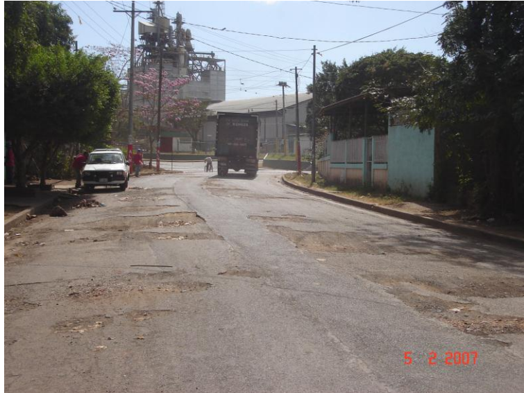
Vista hacia las instalaciones de Nutrientos MEBASA sobre el tramo 1 Aquí está sobre la curva horizontal 1 Dirección O-E
