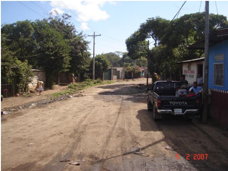
Vista de curva horizontal 2 hacia MEBASA Dirección Oeste -Este
