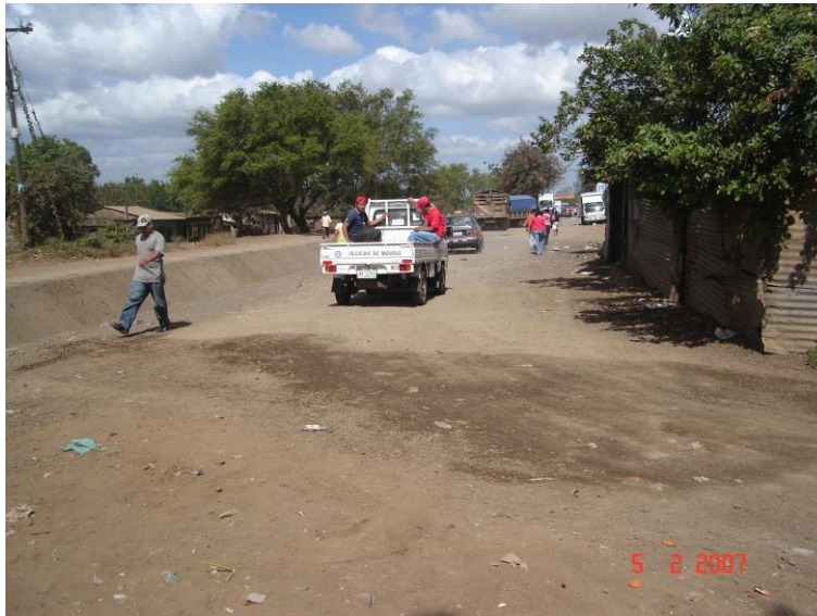
Vista al cauce que está al final del tramo 5 (Estación 0+757), hacia depósito de basura del Mercado. Dirección S-N
