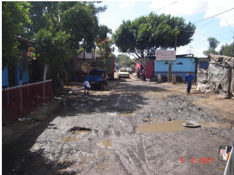
Vista del tramo 4 desde su intersección con el Tramo 1 (PI-7) Dirección N-S
