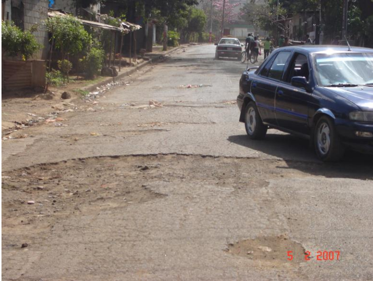
Parte asfaltada del tramo 1 (MEBASA - LA AGUJA) se puede observar en la grafica el mal estado que presentan la carpeta asfáltica. Al fondo se puede notar la Curva horizontal 1 Dirección Este - Oeste
