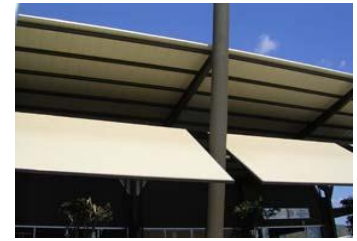
Foto N° 14: Cubierta TS Fuente: Thermotec
