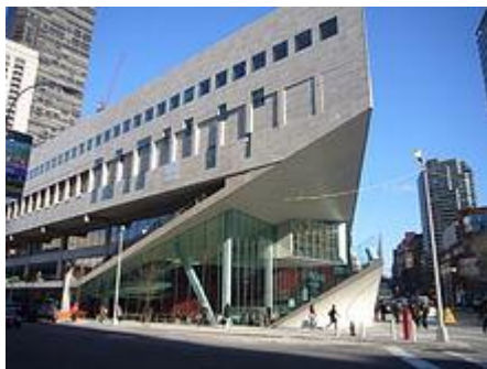
Foto 31: Fachada Escuela Juilliard Fuente: es.wikipedia.org
