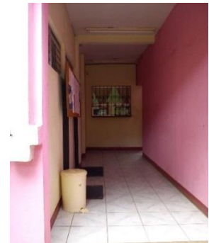
Foto No°40: Infraestructura del Conservatorio de la UPOLI Fuente: Propia
