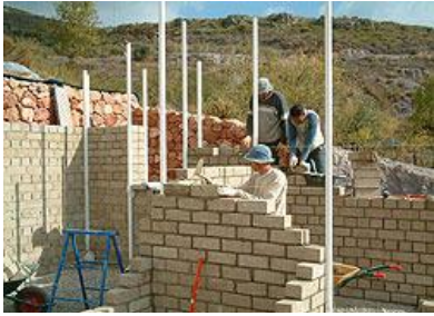
Foto No 21: Proceso Constructivo del Ladrillo de Barro y paja Fuente: El adobe (ladrillos de barro y paja)
