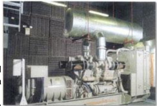
Foto N° 13: Fabricación del Barrier Fuente: Thermotec
