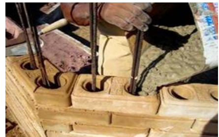
Foto N° 20: Ensamblaje de Ladrillo Ecológico Fuente: Sistemas de construcciones ecológicas
