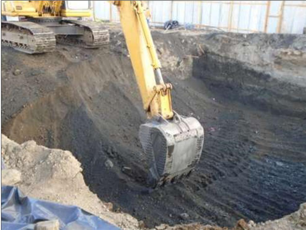
**Foto 1. Fosa excavada en extracción de tanques**
