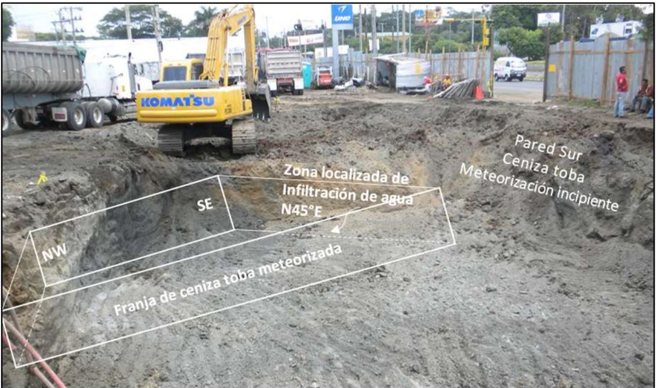
Foto 7. Fosa excavada en extracción de tanques
