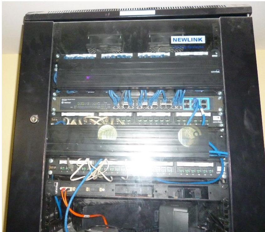
Rack de interconexión de red de ubicado en edificio de imagenología
