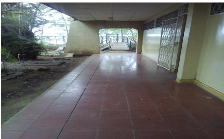
Primer Pabellón Escuela Normal Ricardo Morales, Aulas de primero y segundo año.
