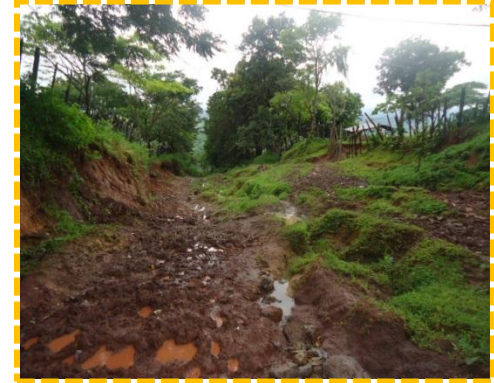
Durante la época de invierno el camino se deteriora.
