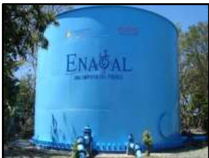
Tanques de Agua, Municipio de Santa Teresa
