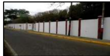
Carretera que Comunica Municipio de San Marcos, Carazo con el Municipio de La Concepción, Masaya
