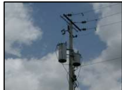
Tendido Eléctrico, Casco Urbano, Municipio de La Paz
