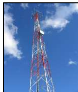
Antena Ubicada en el Municipio de Dolores
