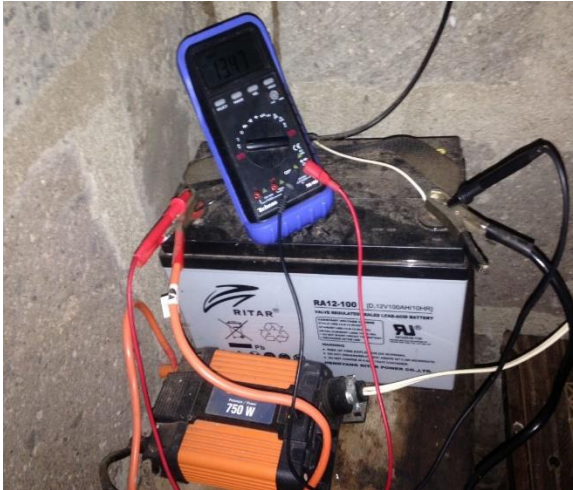
figura 50: acumulador e inversor
