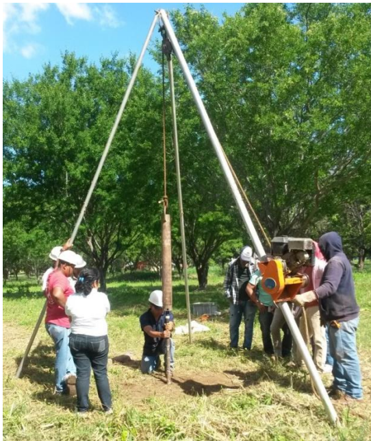
c) Ejecución de la prueba SPT
