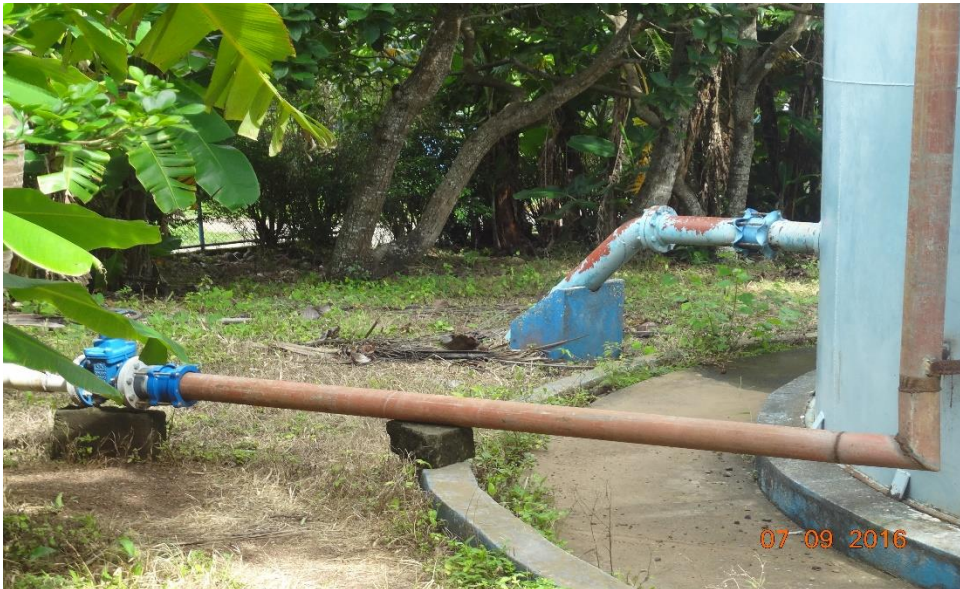
Fuente: Foto tomada por E. Duarte, 2016 Ilustración 17: Línea de conducción, fuente área rural
