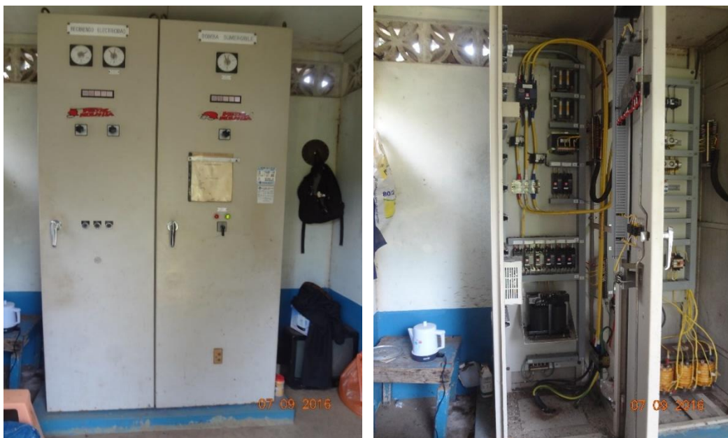
Ilustración 16: Caseta eléctrica para control de equipo de bombeo
