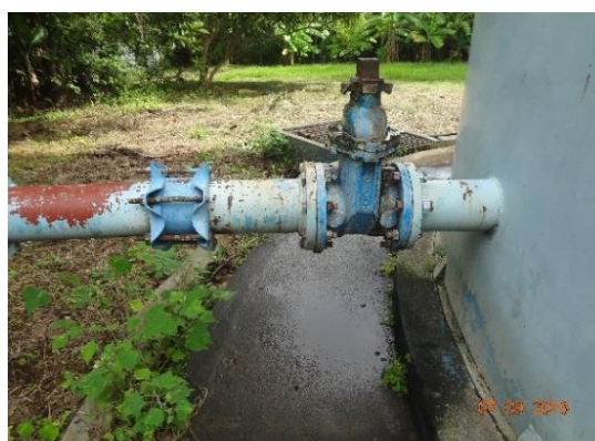
Fuente: Foto tomada por E. Duarte, 2016 Ilustración 20: Tubería de salida al tanque.
