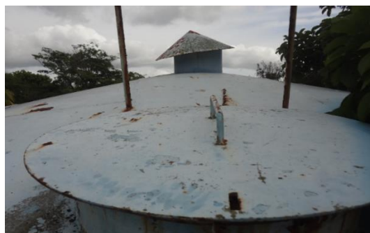
Ilustración 22: Tubería de rebose y techo del tanque de almacenamiento
