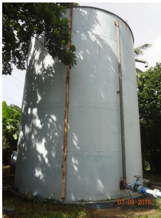
Fuente: Foto tomada por E. Duarte, 2016. Ilustración 21: Tanque de almacenamiento
