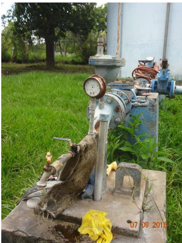
Fuente: Foto tomada por E. Duarte, 2016 Ilustración 19: Fuente, manómetro, llave de paso y grifo ubicada en área urbana
