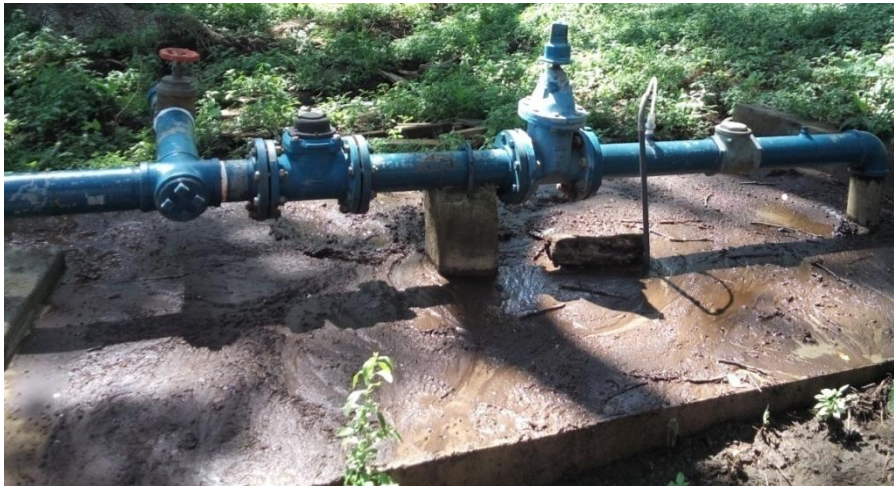
0-49 Medidor de agua
