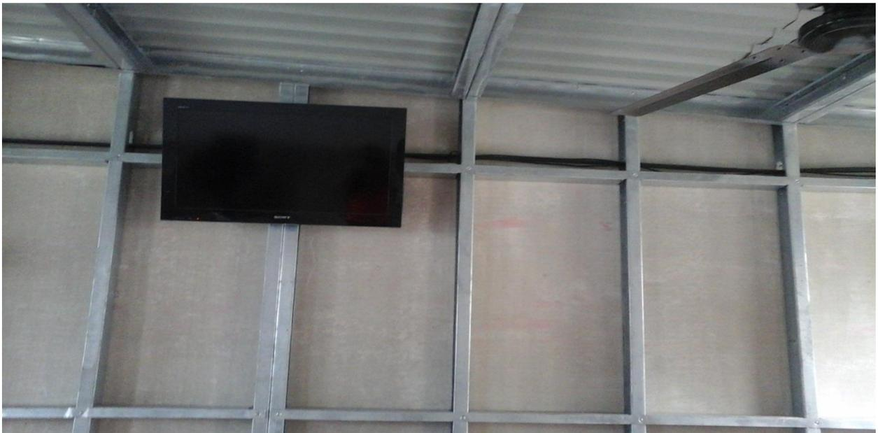
*Fotos 2 - Estructura principal Steel Framing sin cerramiento interno.*
