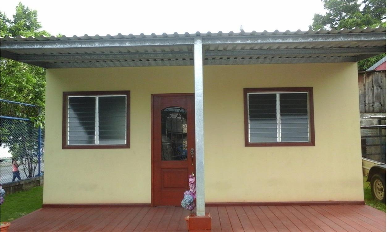
*Fotos 1 - Vivienda modelo de 36 m<sup>2</sup> construida con la tecnología Steel Frame.*
