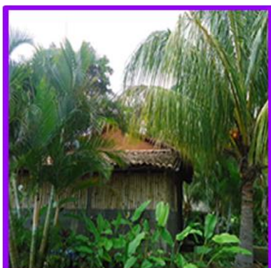
Imagen N° 24: Fachada de la Cocina
