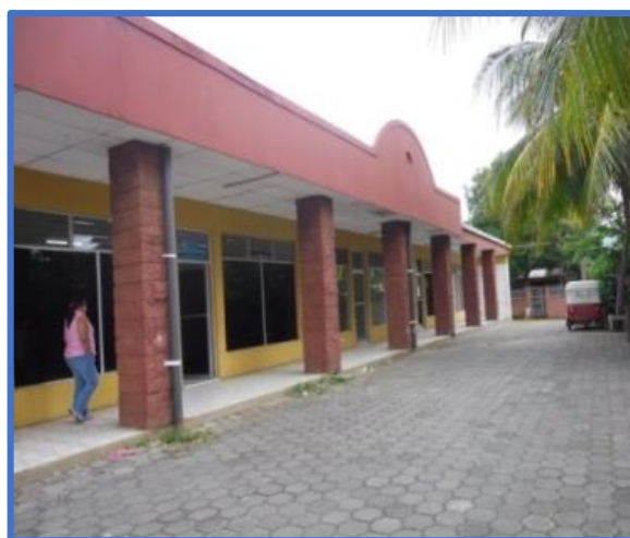
Imagen N° 56: Instalaciones de Plaza Ticuantepe
