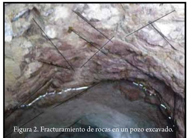
Figura 2. Fracturamiento de rocas en un pozo excavado.
