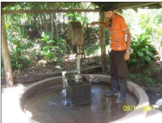
Foto 5. Pozo Perforado de Bomba manual.
