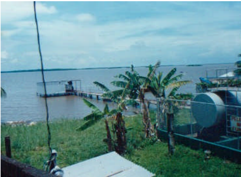
Foto # 7. Almacén del combustible para el transporte acuático en la ciudad de Bluefields.
