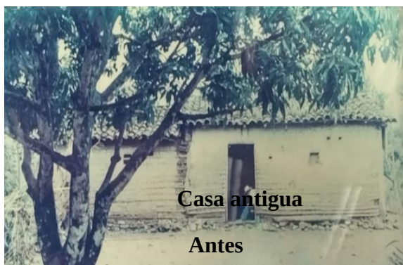
Imagen 22 Viviendas de la comunidad El Chile Fuente (Elaboración Propia)
