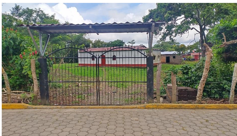
Imagen 27 Iglesia Católica Fuente: Elaboración propia
