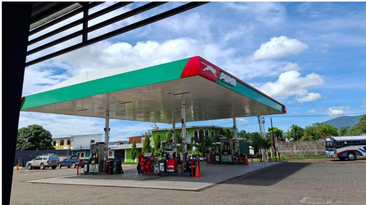
Anexo No.7. Fotografías de la gasolinera Puma, Santa Lucia. Estelí, Nicaragua.
