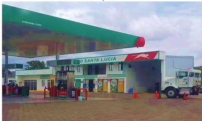
Figura 3. Fachada de la Gasolinera Puma Santa Lucía, Estelí
