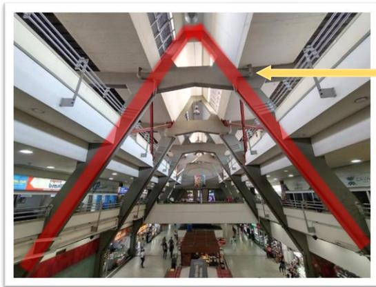
**Estructura nervada con forma de V invertida:** Esta es la encargada de soportar el peso de las losas, siendo además una característica muy distintiva del edificio.
