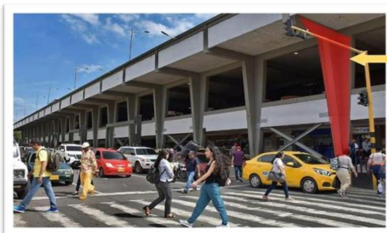
**Estructura de columnas de concreto con un voladizo:** consta de una sucesión de columnas de planta cruciforme que forman un pórtico en torno al edificio, sobre este sobresale un voladizo en forma de terraza
