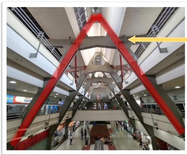
**Estructura nervada con forma de V invertida:** Esta es la encargada de soportar el peso de las losas, siendo además una característica muy distintiva del edificio.
