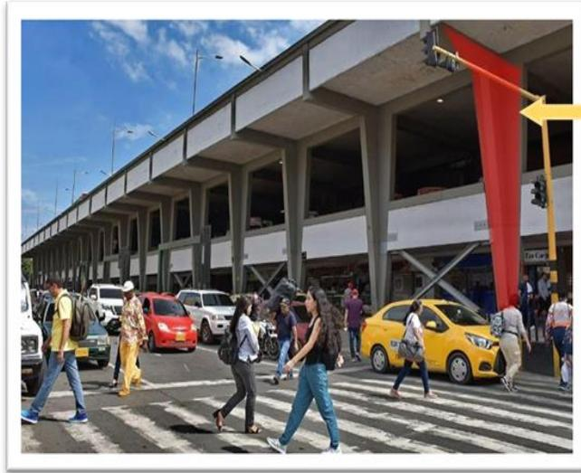
**Estructura de columnas de concreto con un voladizo:** consta de una sucesión de columnas de planta cruciforme que forman un pórtico en torno al edificio, sobre este sobresale un voladizo en forma de terraza
