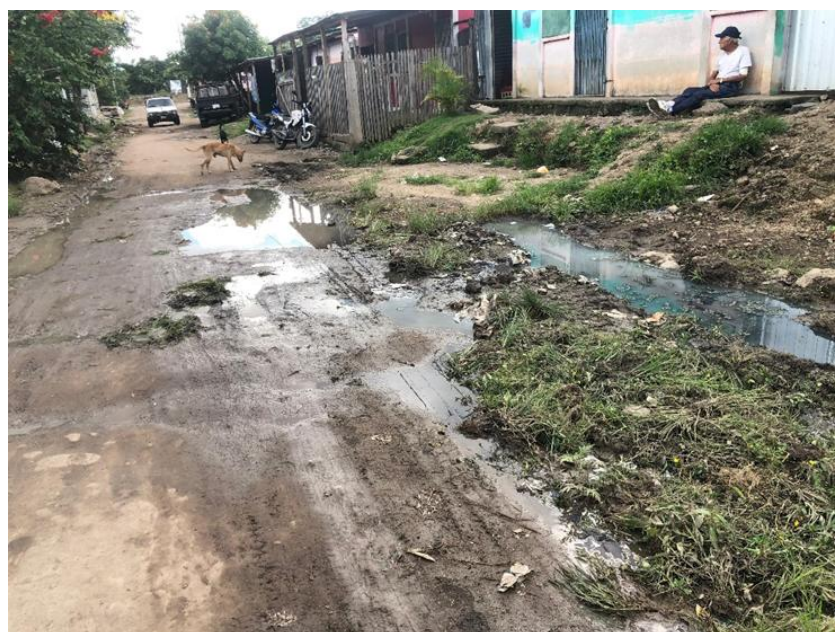
Barrio Villa Cuba. Aguas residuales tiradas directamente a las vías públicas.
