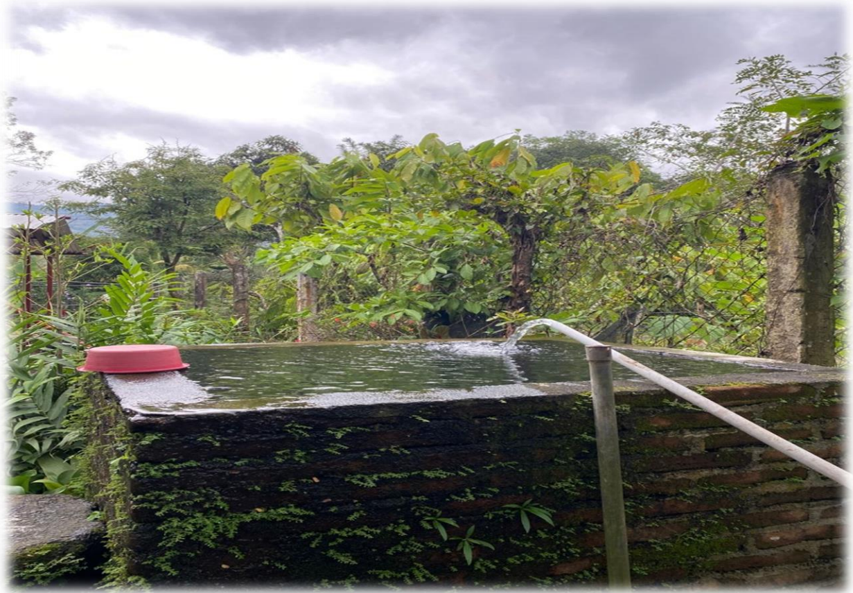
Imagen 17. Pila de almacenamiento de agua, comunidad La Estrellita
