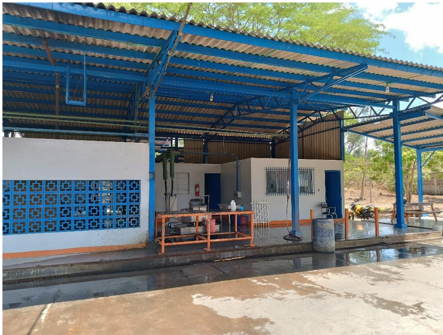
Ilustración 8. Vista frontal de la infraestructura del centro de Acopio y Enfriamiento de leche AGROLAC.
