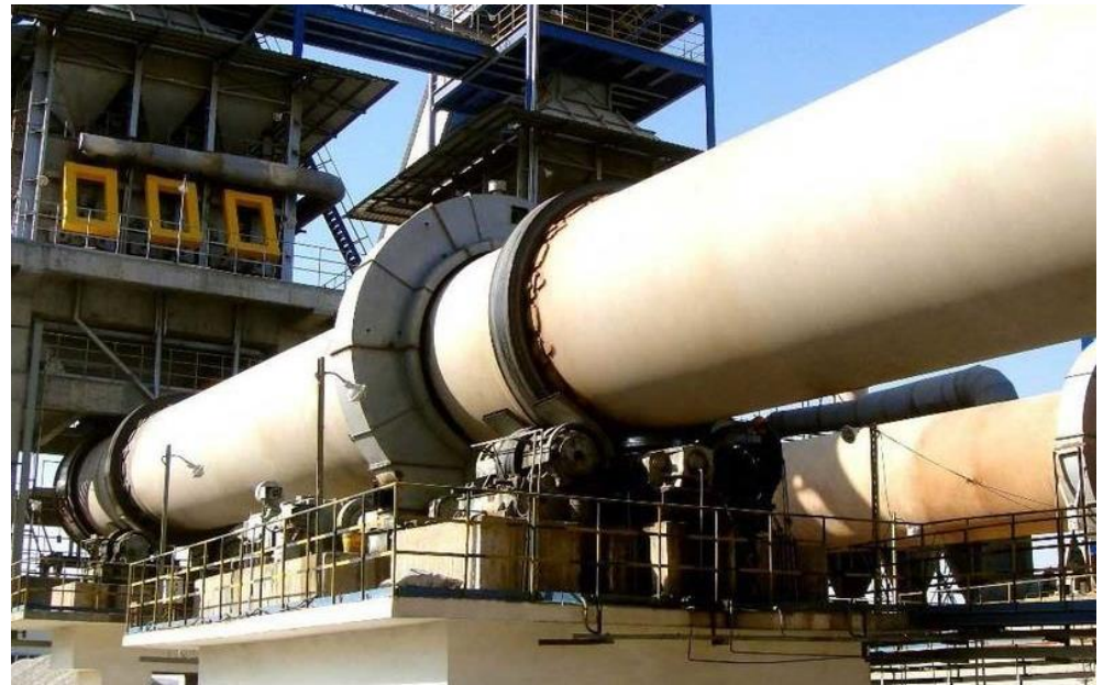
Horno de cemento rotatorio, para la combustión eficiente de los residuos
