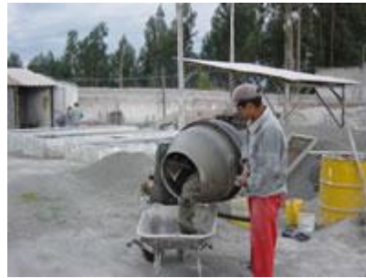
ILUSTRACIÓN 8. PREPARACIÓN DE LA MEZCLA
