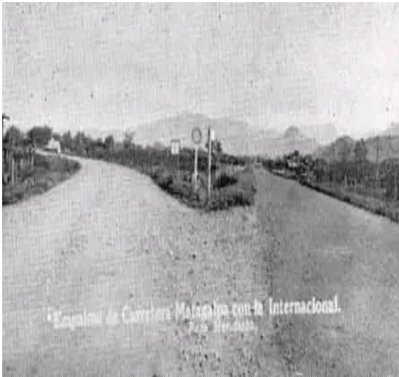
Imagen 6. Empalme de Sébaco. Fuente: David Marengo. 11/07/2022
