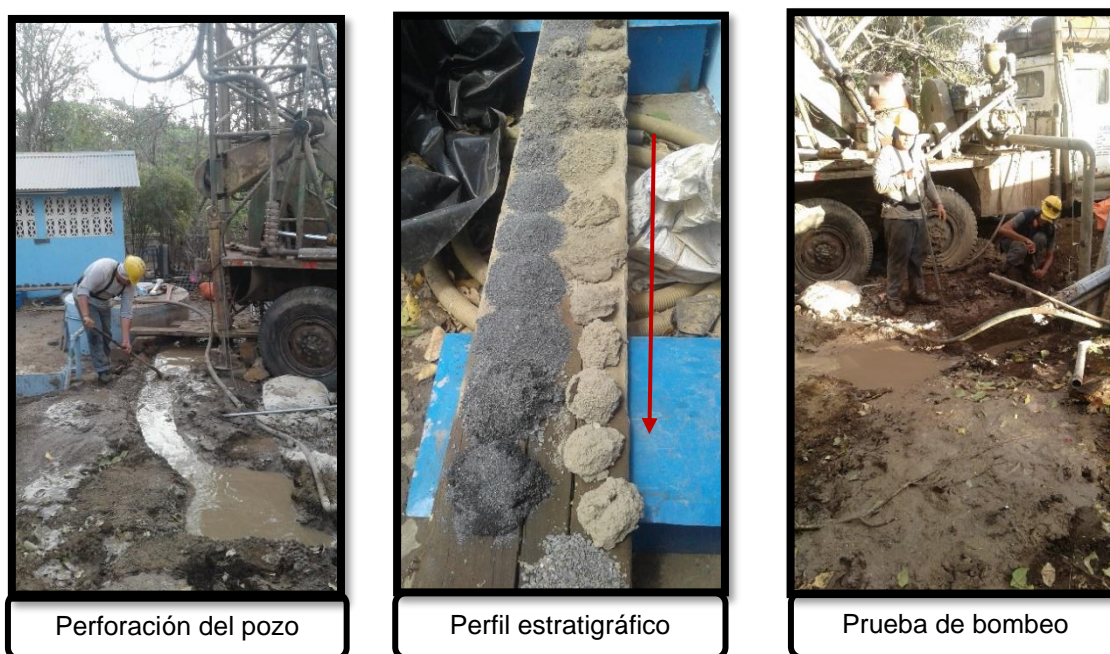
Foto 12. Perforación, estratigrafía y prueba de bombeo en pozo N°4 Horconcitos.
