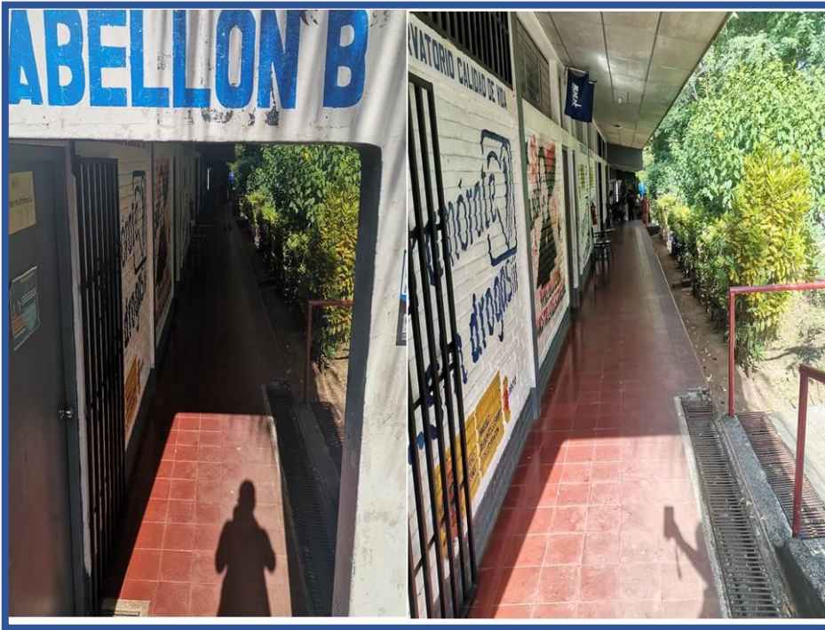
Figura 76. Pabellón B, Área de Laboratorios.
