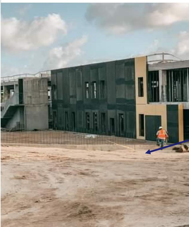
Como podemos observar, el uso de material liviano para levantar paredes es un sistema constructivo muy utilizado en EE. UU, ya que este les facilita el trabajo y les ahorra tiempo, St. Jude no fue la excepción en esta técnica constructiva, podemos ver parte de sus paredes construidas de material liviano.
