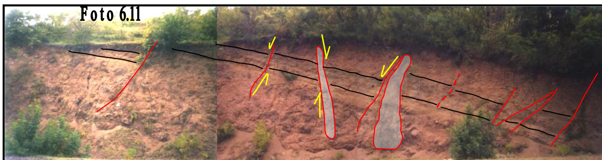
Foto 6.11. Coordenadas: 542887 E – 1490840 N
