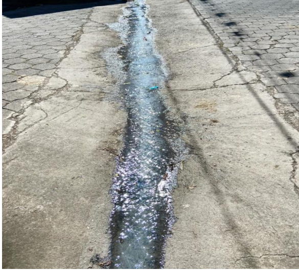
Fig. 12: Aguas domesticas depositadas en las calles
