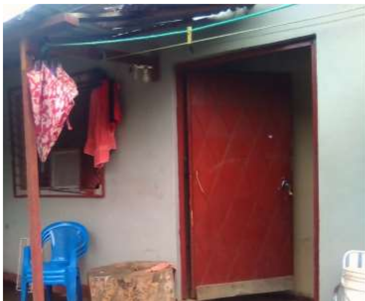
Figura. 72 Vivienda vista de frente.
