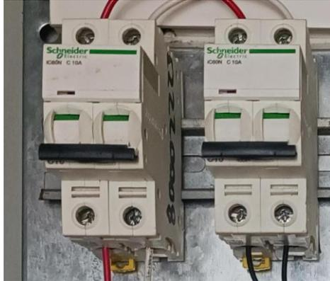
*Nota.* En esta imagen se observan dos interruptores magneto-térmicos utilizados como protección de los contactores y del Zelio Logic.
