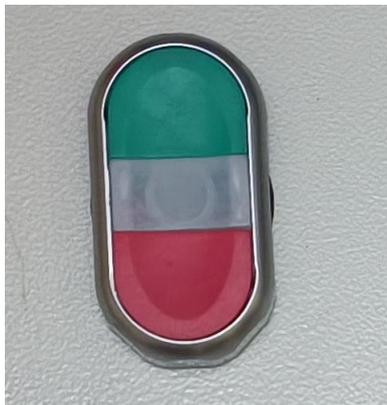
*Nota.* En la imagen se observa el pulsador utilizado para iniciar o apagar el motor.
