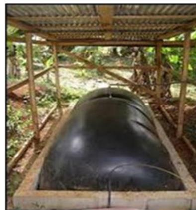
**Foto 3. Biodigestor instalado produciendo biogás.**
