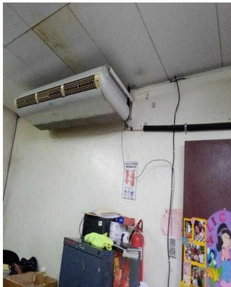
Cielo falso dañado por las lluvias provocando goteras.
