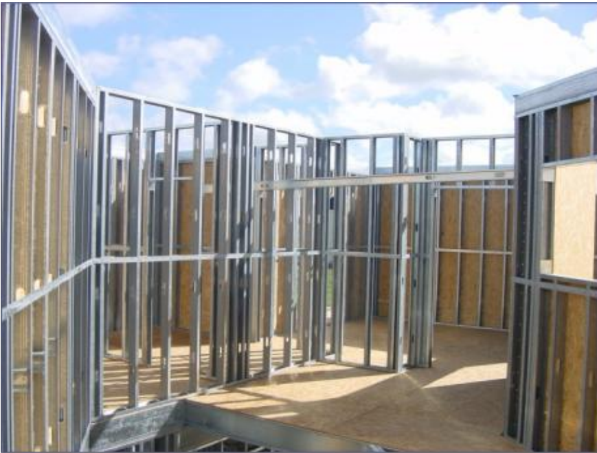
Figura 4 Estructura de paredes y/o particiones S. F
