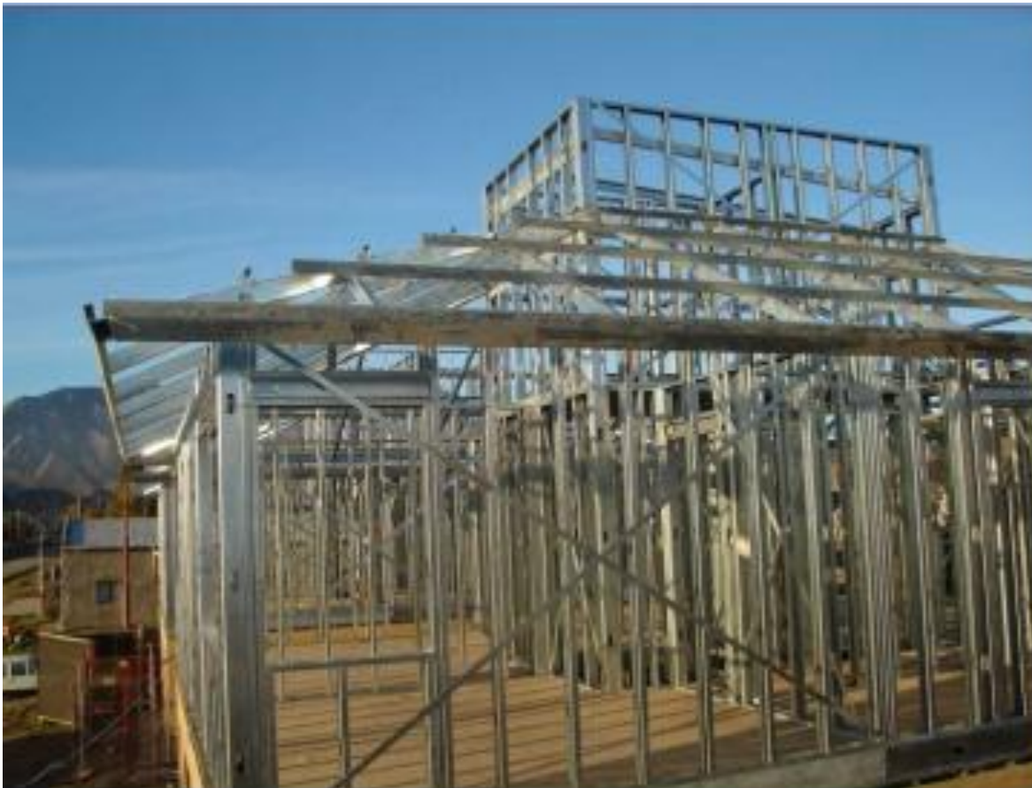
Figura 2. Estructura y perfilería del sistema Steel Framing
