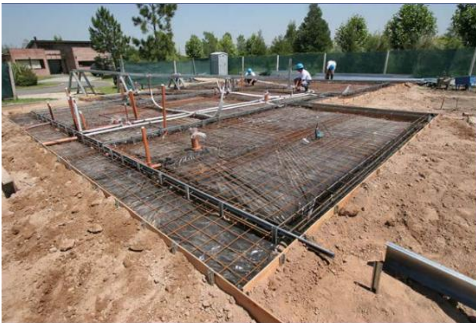
Figura 1. Armado de zapata corrida o viga de fundación Steel Framing
