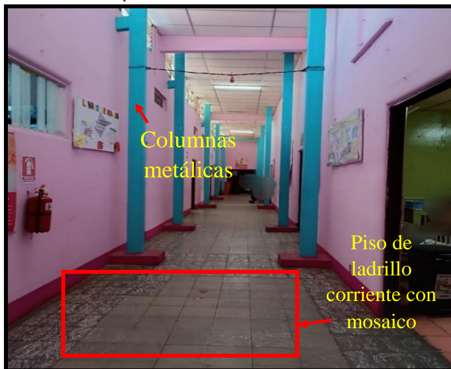
Pasillo de hospitalización
