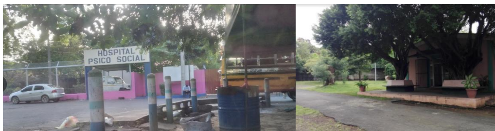
Exterior Hospital Psico Social Managua. Fuente: Google Maps.
