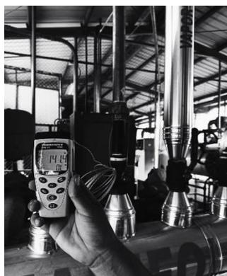
metros por toda la tubería en general, esto tomando en cuenta que existe tubería aislada y no aislada, restamos 40W/m a los 279W/m para obtener el valor real sobre la tubería sin aislamiento, por consiguiente, equivale a 239W/m.
