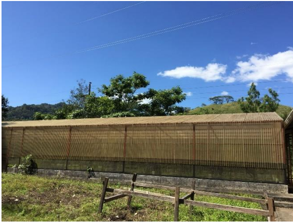
Exterior de túneles de secado Fuente: Propia
